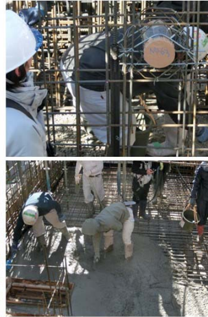
第3回目 コンクリート打設初日
